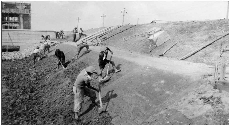
La costruzione degli argini - foto archivio personale Alverio Zuppet
